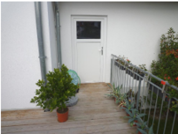
...Zugang in die Garage
